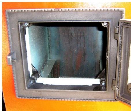
Рисунок 5 – Топочная дверка котла
