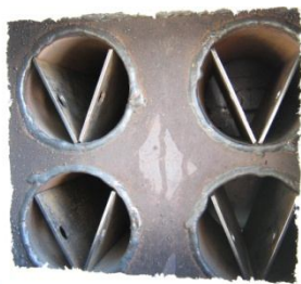
Рисунок 2 – Установка турбулизаторов
